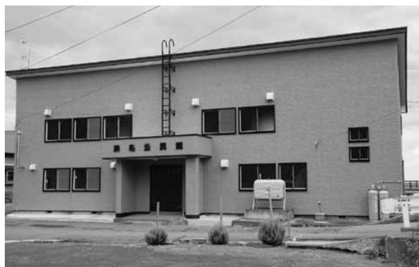
外壁や窓の改修が行われた浜名公民館
