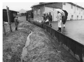
常任委員現地視察 (村元地区八甲荘裏の排水)
