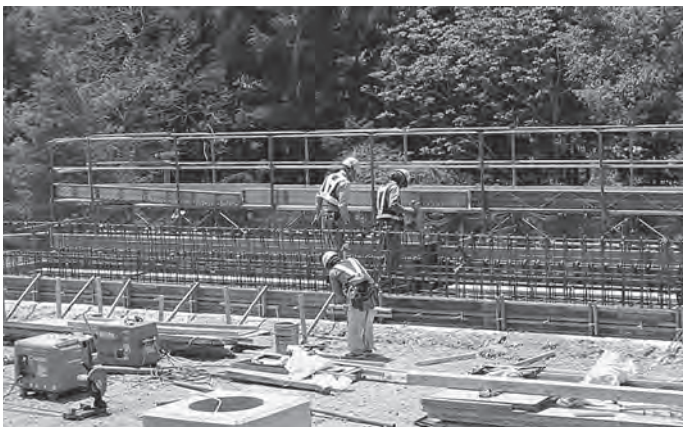
着々と進む新幹線工事
