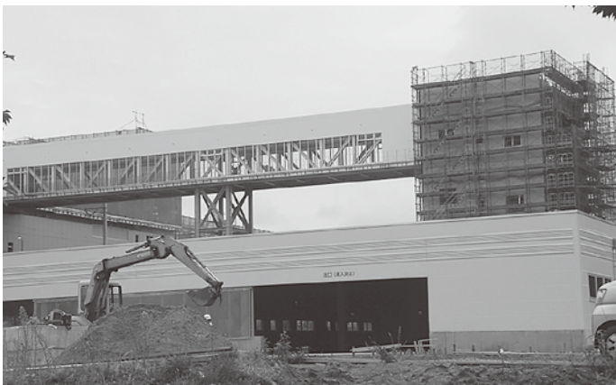
開業へ向け、着々と工事が進む現場
