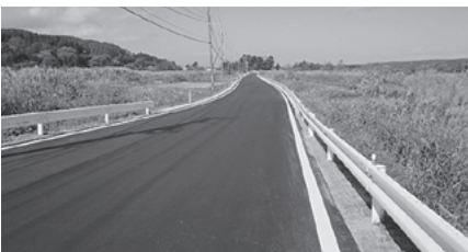
①大川平下町1号線道路改良工事
