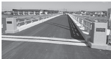
②あすなろ橋橋梁補修工事
