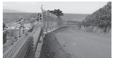
③大泊1号線防雪柵設置工事
