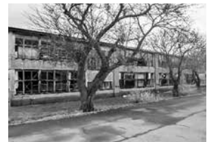
老朽化が進み解体した今別小学校舎
