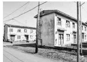
解体した町営団地1、3号棟
