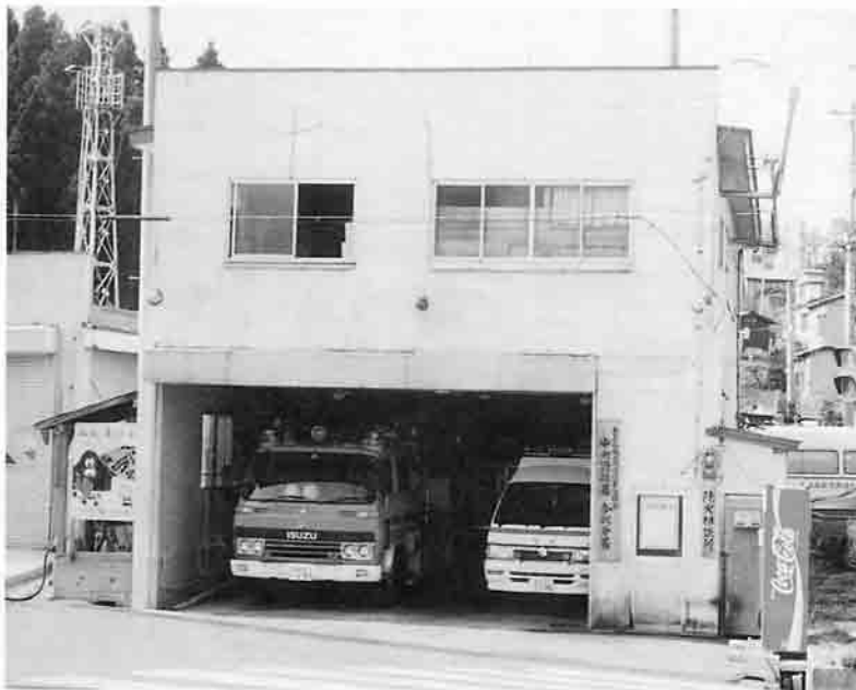
▶老朽化し移転建設が待たれる 広域消防「今別分署」
