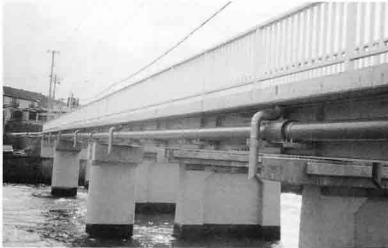
▲今別橋添管移設工事
