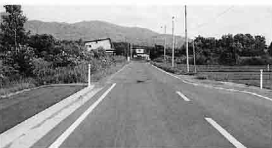
村元・大川平線拡幅工事
