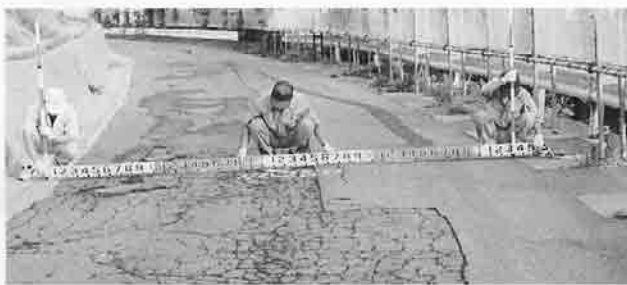
▲大泊地区災害復旧工事
