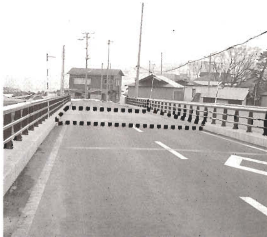
▲ 今別橋のグレーチング工法（点線部分）
