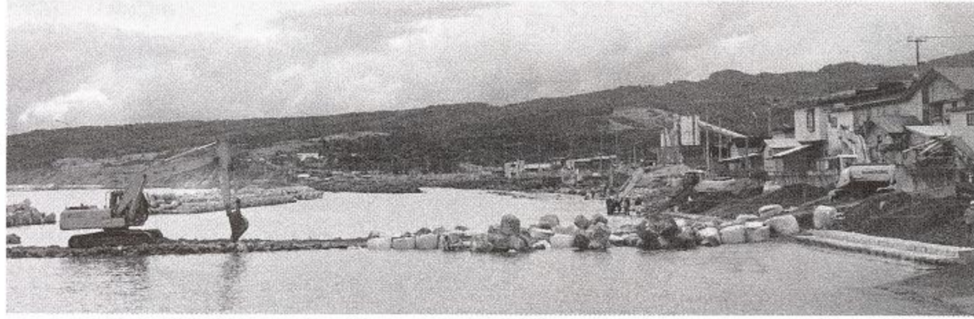
▶村元海岸の整備工事
