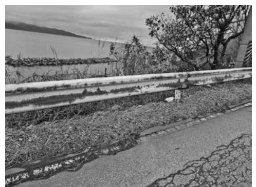
大泊1号線沿いの腐食したガードレール
