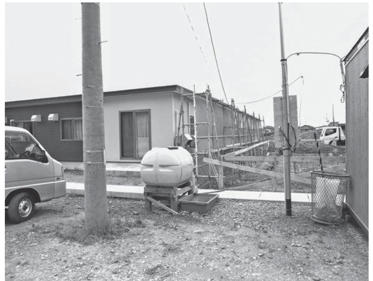
完成した新しい町営住宅の周辺の様子
