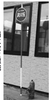
消火栓と標識
