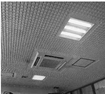
入替え工事を行うエアコン
