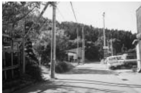
交通の妨げとなっている大川平地区の電柱
