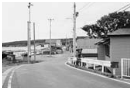
拡幅工事が予定されている村元地区の国道
