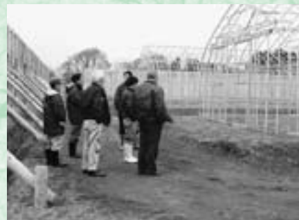
パイプハウス建設現場を視察する産業建設常任委員会委員
