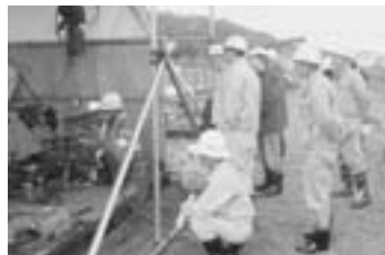
レール溶接作業を視察する委員
