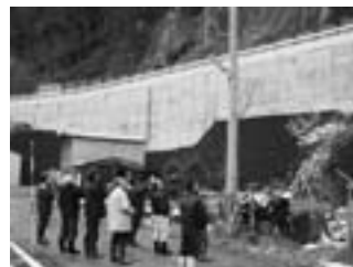
褒月七曲りの工事現場 を視察する常任委員
