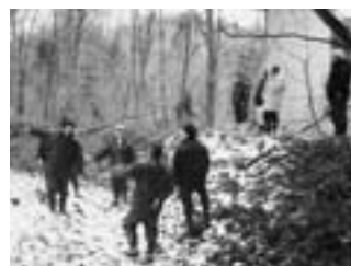
大川平新堰の素掘り用水路 の現状を見る
