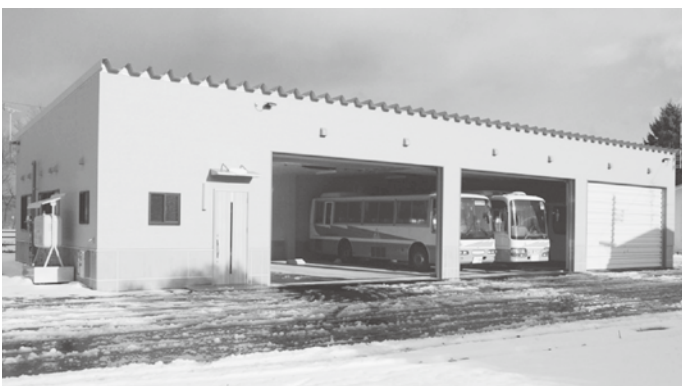
平成23年度に整備された公共用バス待機場
