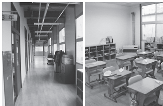
増築工事が完了した教室や廊下
