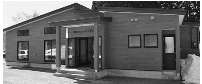
完成した関口コミュニティハウス
