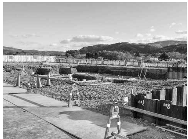
消防署今別分署造成工事の様子
