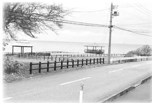
写真手前の柵を取り払い、鑄釜崎キャンプ場への進入道路を取り付ける予定です。
