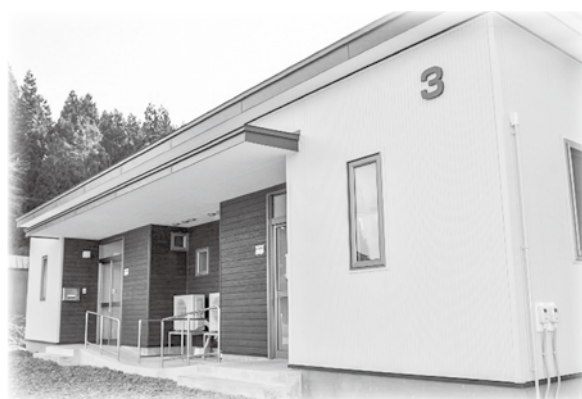
3月に完成した町営住宅3号棟
