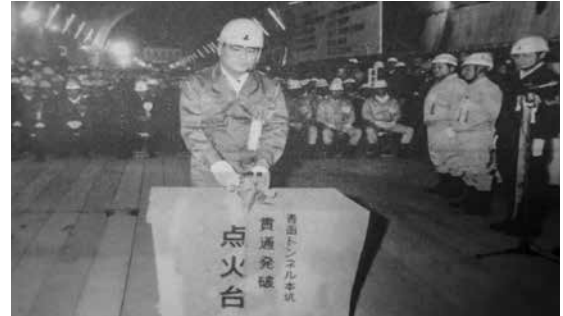
▲昭和60年3月10日午前10時5分30秒。山下徳夫運輸大臣が発破スイッチをひねる瞬間。工事関係者ら1300人が見守る中で行われた（写真提供＝青函建設局）＝「広報いまべつ」昭和60年4月号を撮影。
