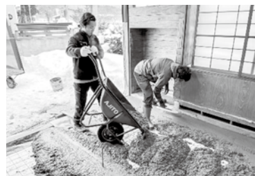
まだ元気に生コンを運んでいる様子
