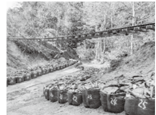
枝沢橋りょう応急処置後 幅28m高さ4.5mの盛り土が流出
