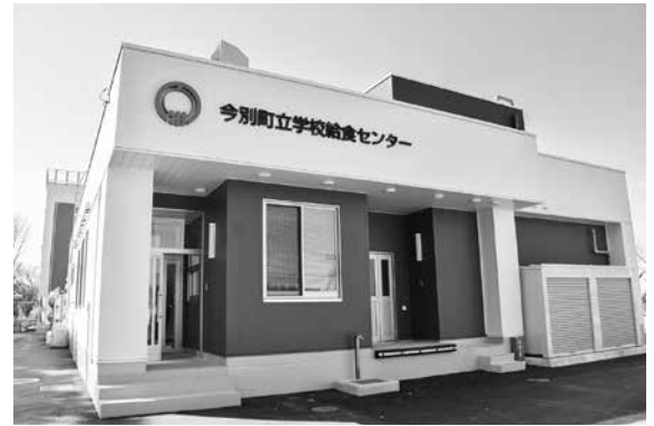
給食センター外観
