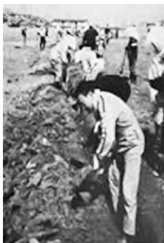
◀水道管を敷設するために、手掘りの労力奉仕を行う八幡町町内会員（写真：「広報いまべつ」299号（平成元年6月号）から複写）
