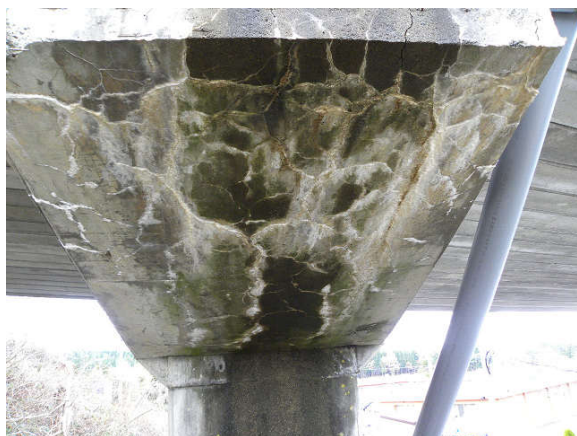
写真-1 長川水源池橋 橋脚(梁部)
