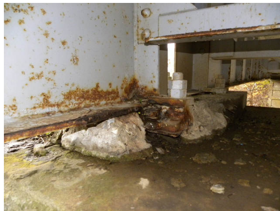
写真-2 大川平橋 沓座モルタル
