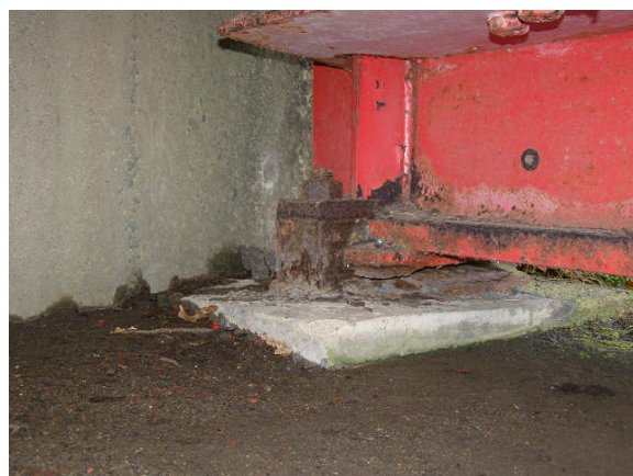
写真-4 第2馬流橋 支承
