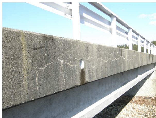
写真-6 槌菱橋 地覆側面
