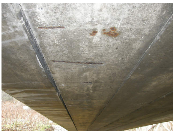
写真-5 与茂内橋 主桁下面
