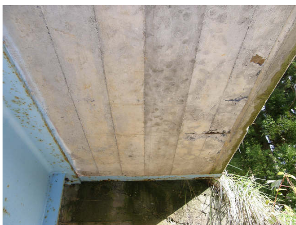
写真-5 上長川橋 床版(端部)
