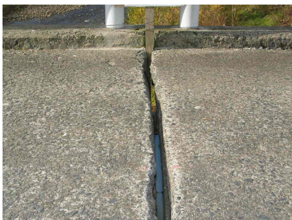
写真-3 大川平由四良川橋 伸縮装置
