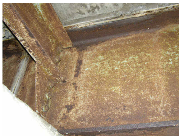
写真-6 堀替橋 主桁(端部)
