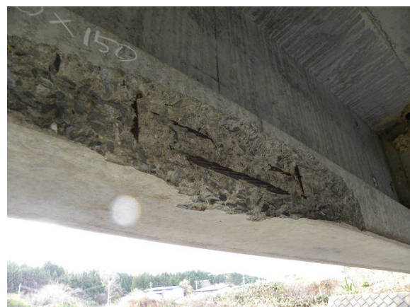
写真-4 宇賀台橋 主桁
