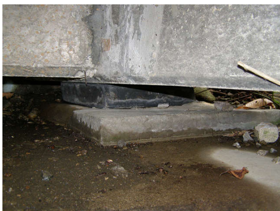
写真-3 安衛兵沢橋 支承
