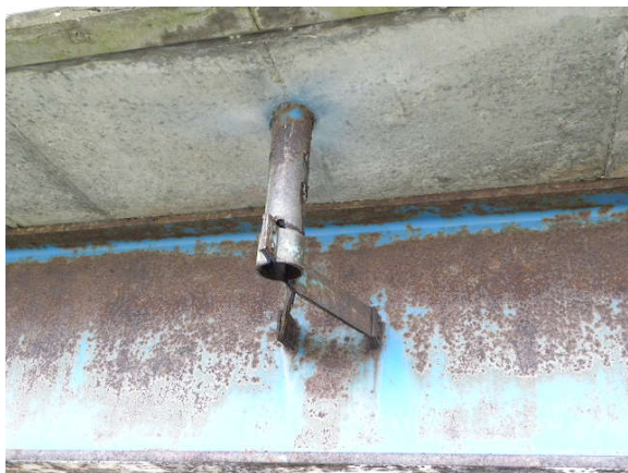
写真-1 あすなろ橋 排水管
