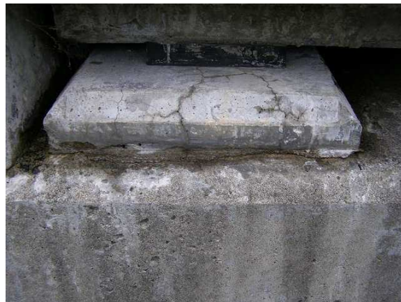
写真-8 新馬流橋：沓座モルタル
