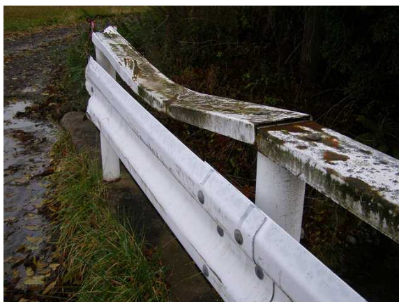
写真-7 上股橋 橋脚(梁部)
