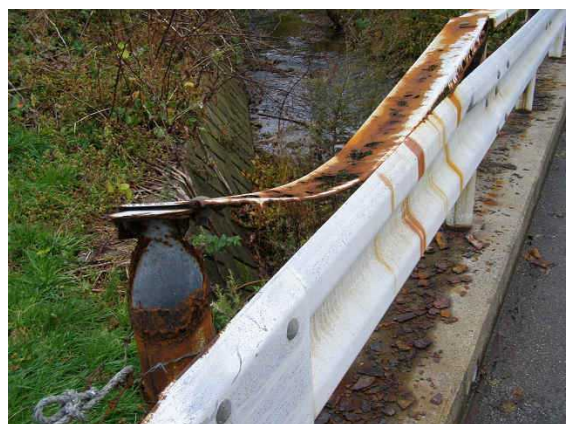
写真-3 山崎中宇田1号橋：防護柵
