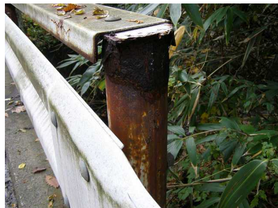
写真-4 山崎中宇田2号橋：防護柵
