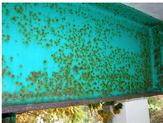
写真-1 西田都市計画橋：主桁
