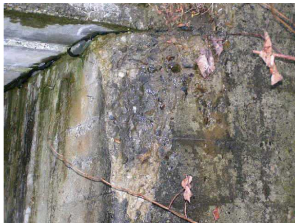
写真-10 今別母沢 10 号橋：橋台
