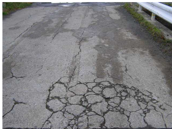
写真-2 鍋田橋：コンクリート舗装
