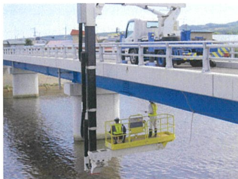
写真 2-1 点検作業状況(参考:あすなろ橋)
