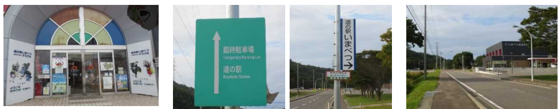
左側：道の駅いまべつ正面入口 看板絵が劣化している。 中央：道の駅いまべつへの案内表示板 「分かりづらい」などの苦情がある。 右側：「いまべつ総合体育館」等への案内表示板がない。
